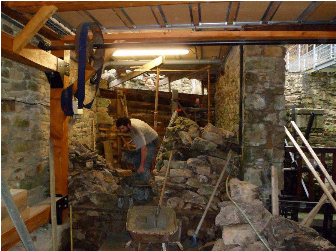
Démolition du mur ( côté intérieur )
