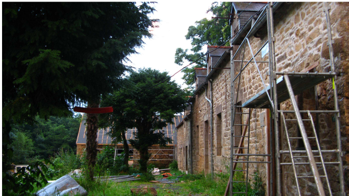
Travaux en cours
