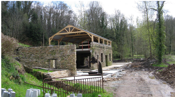
Moulin début des travaux
