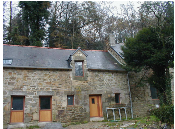
En cours de travaux
