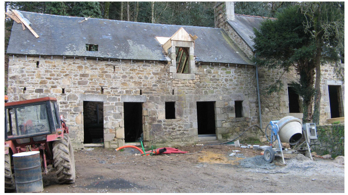
En cours de travaux
