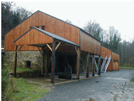
Moulin fin des travaux côté nord ouest
