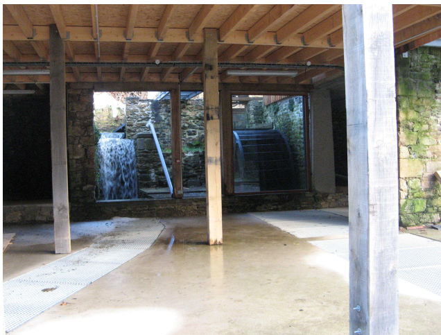
Vue de la roue à aubes depuis l' intérieur du moulin
