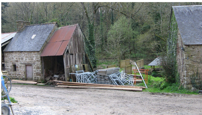
Ty forn ( maison du four ) avant travaux
