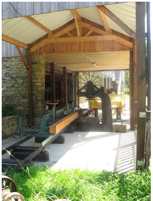
Scierie après travaux
