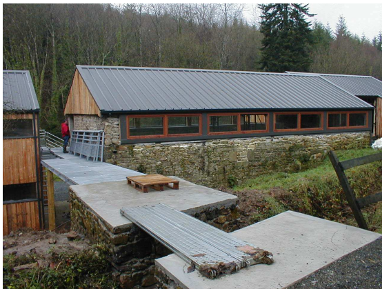
Travaux en cours
