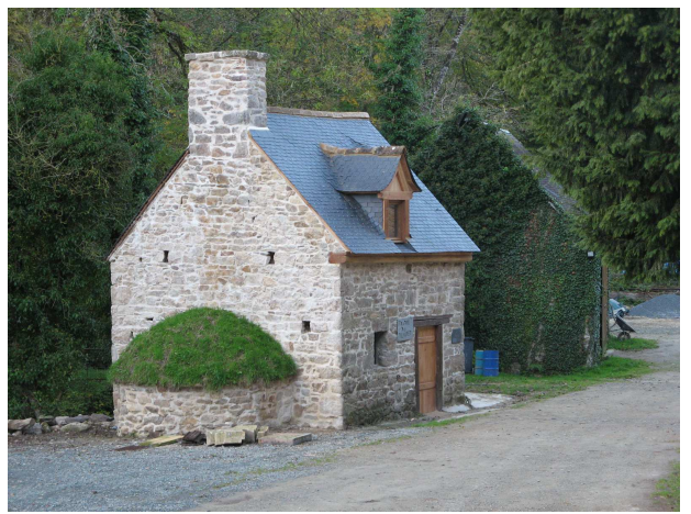
Ty forn après travaux
