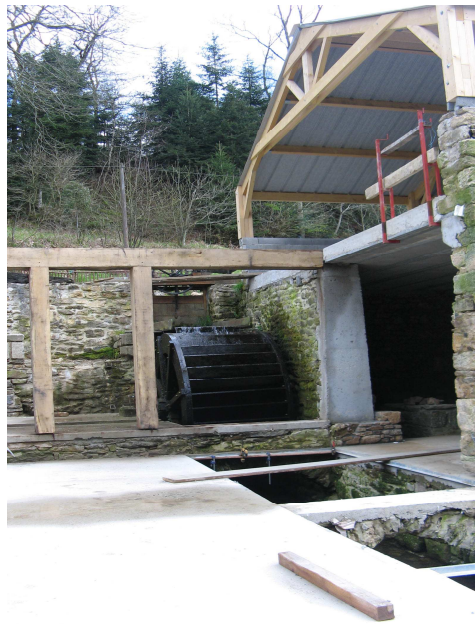
Travaux de reconstruction du moulin
