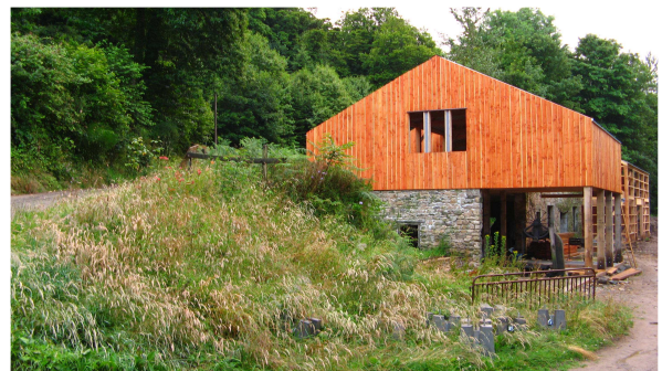
Moulin travaux en cours
