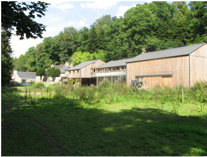
Moulin après travaux côté sud ouest
