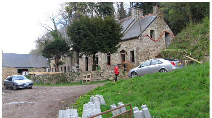
Travaux en cours
